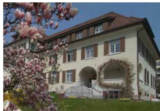
Altersheim Im Grund
