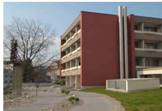
Wohnheim Im Grund
